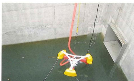
雨水ピット最終槽に設置
